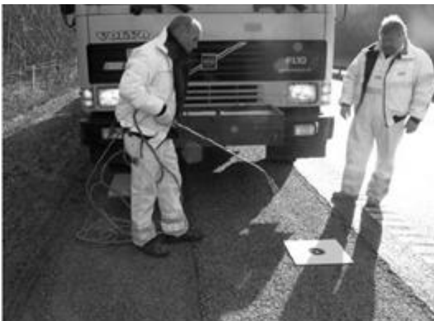
Figura 9 - Pré-sinalização com pintura sobre pavimentação (Elgaard, 2007).
