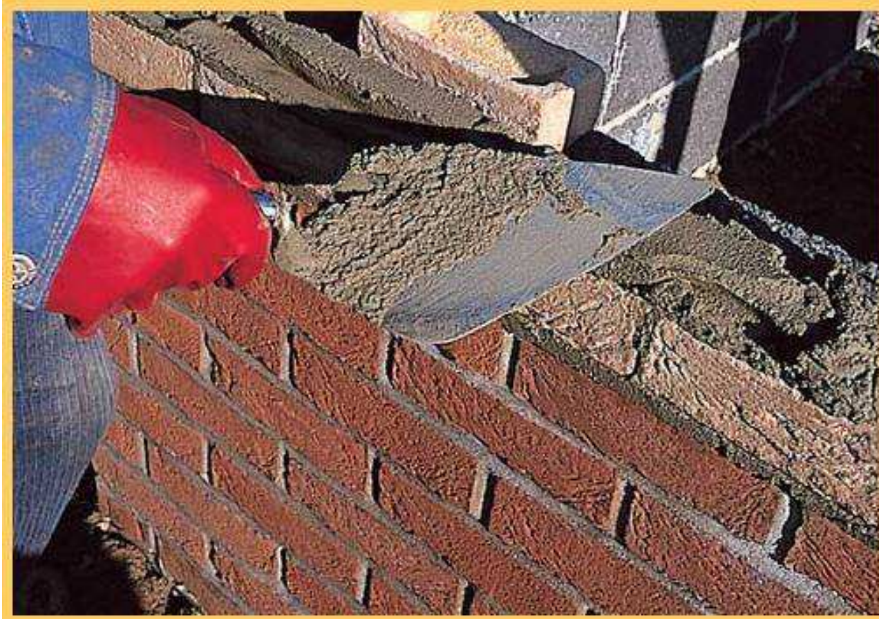
Parede de alvenaria de bloco cerâmico
