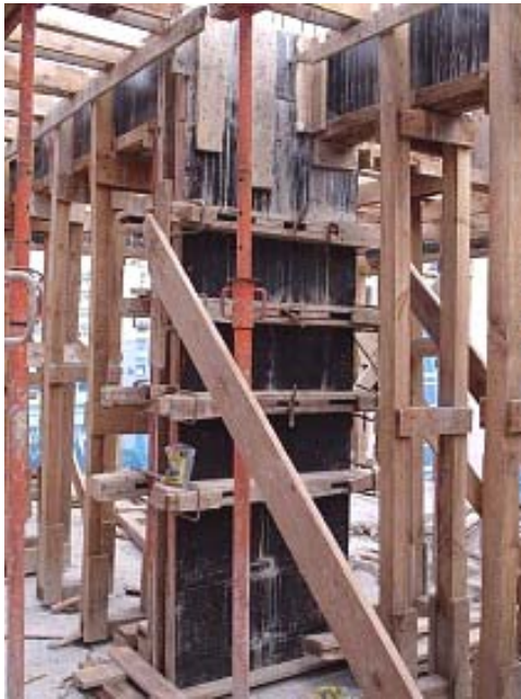
Figura 41 – Montagem de um pilar e detalhe da fôrma.
