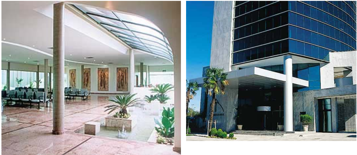
Figura 45 – Pilares em edifícios.
