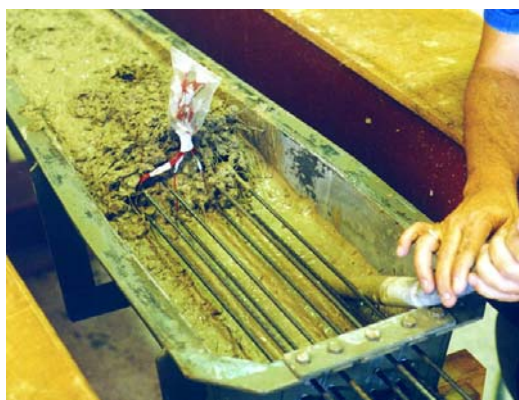
Figura 11 – Preenchimento de uma fôrma metálica com concreto aderente à armadura.
