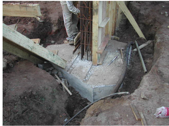
Figura 52 – Desenho esquemático de bloco sobre três estacas e bloco concretado.
