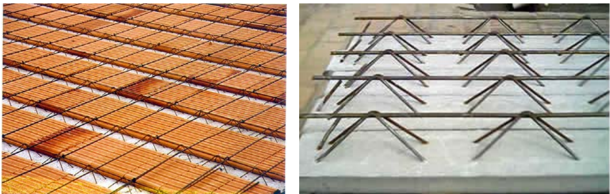
Figura 28 – Exemplo de laje nervurada pré-fabricada do tipo treliçada (FAULIM, 2004).
