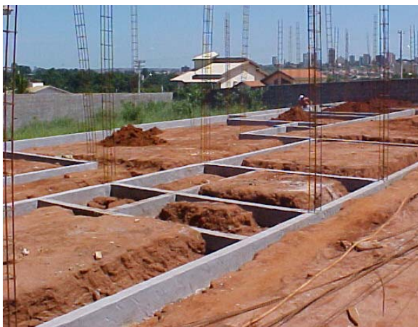
Figura 34 – Vigas baldrames para servirem de apoio das paredes de uma residência.
