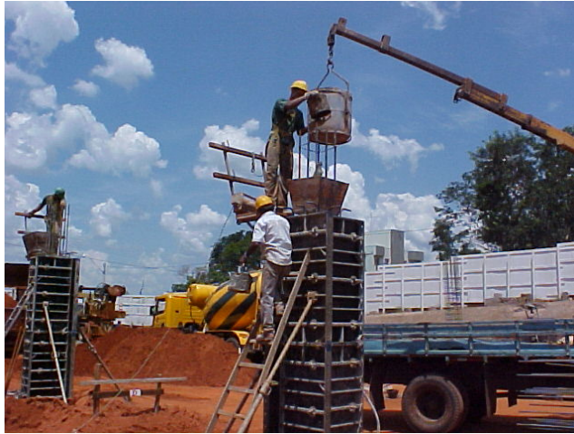
Figura 40 – Pilar sendo concretado e detalhe da fôrma.
