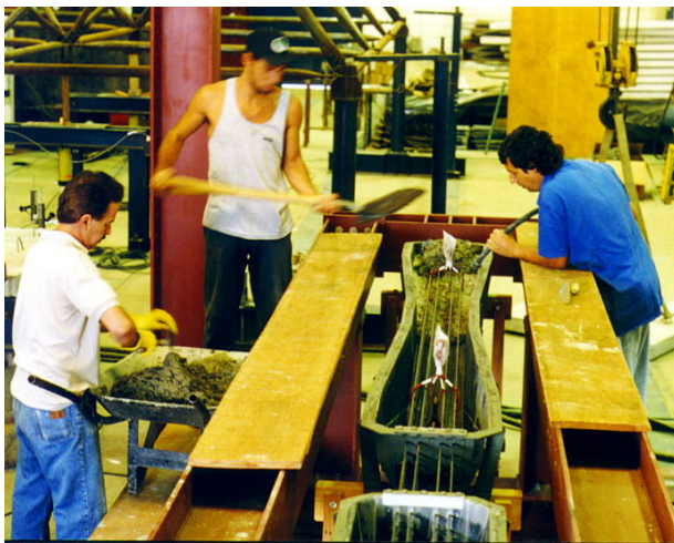
c) Lançamento e adensamento do concreto com vibrador de agulha;
