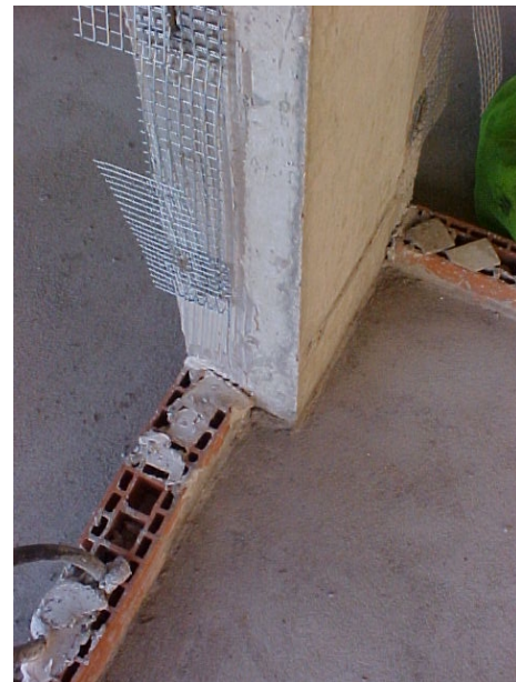
Figura 44 – Detalhes da amarração entre o pilar de edifício e as paredes de vedação.
