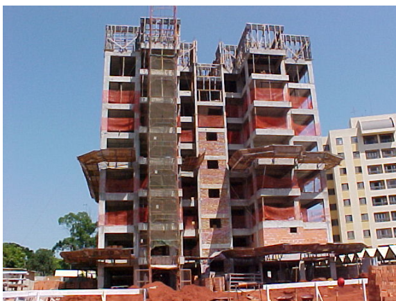
Figura 42 – Pilares num edifício de múltiplos pavimentos.
