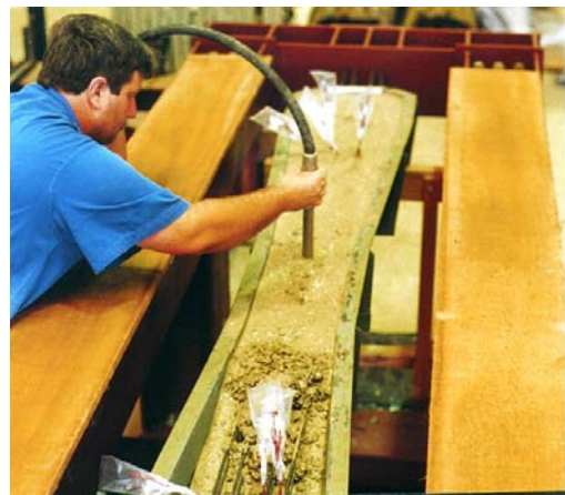
d) Adensamento com vibrador de agulha.
