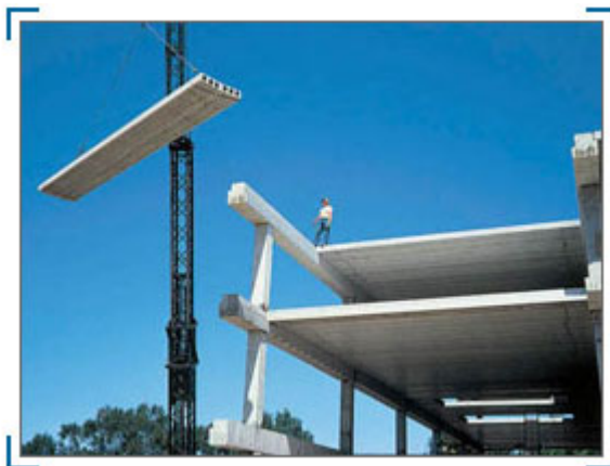
Figura 30 – Laje alveolar de concreto protendido (TATU PRÉ-MOLDADOS, 2004).
