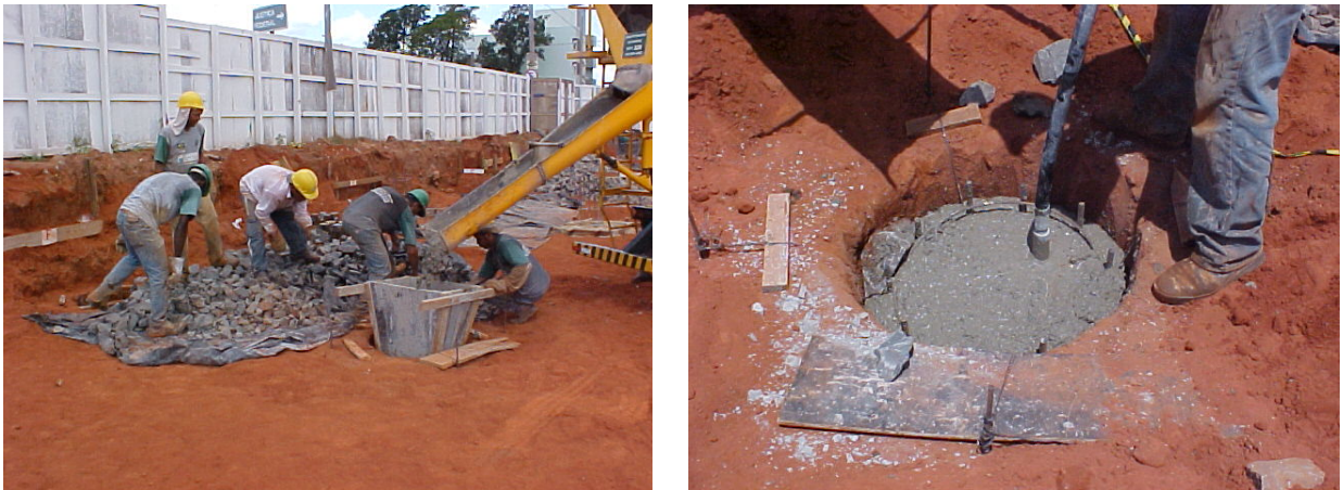
Figura 50 – Lançamento do concreto no tubulão e adensamento do concreto do topo do fuste.
