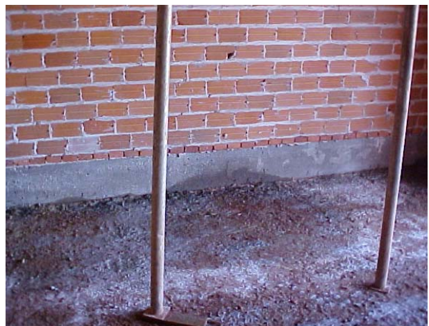
Figura 35 – Viga invertida na base de uma parede.
