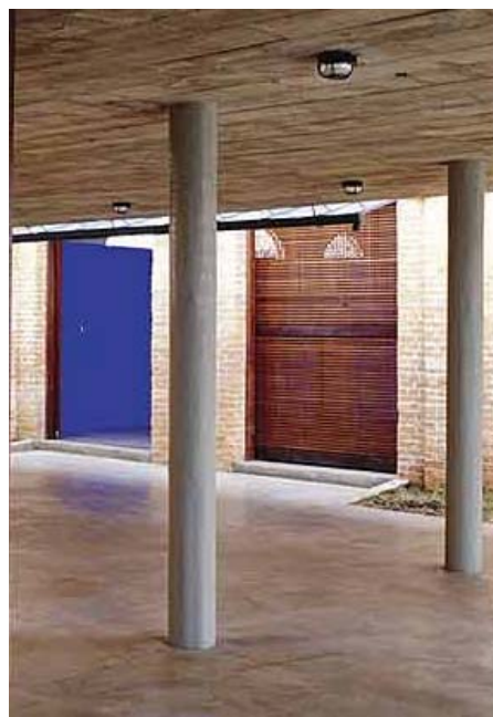
Figura 24 - Laje lisa (apoiada diretamente nos pilares).
