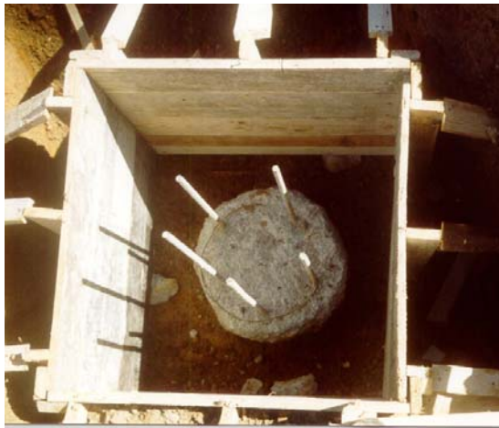
Figura 53 – Bloco sobre uma estaca em construção.
