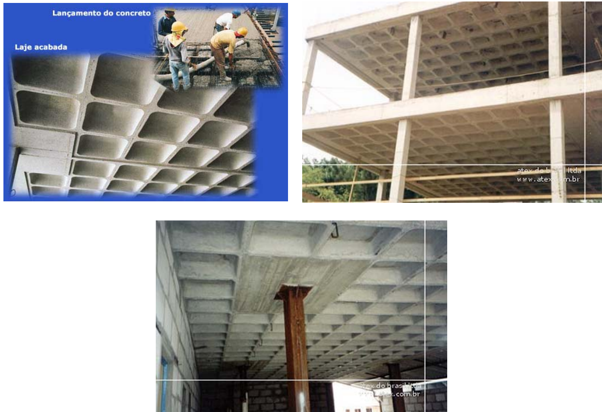
Figura 27 – Lajes nervuradas sem material de enchimento.
