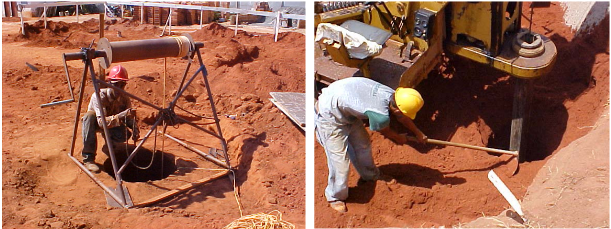
Figura 49 – Tubulões sendo escavados manualmente e com equipamento.
