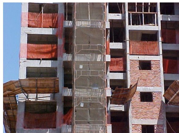
Figura 42 – Pilares num edifício de múltiplos pavimentos.
