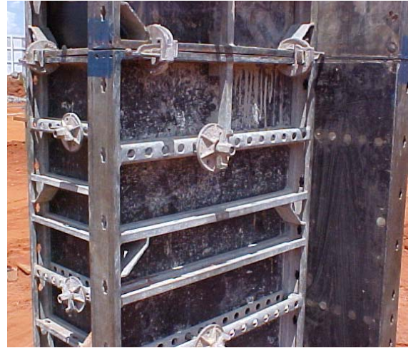
Figura 40 – Pilar sendo concretado e detalhe da fôrma.
