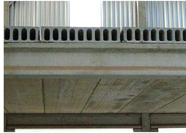
Figura 30 – Laje alveolar de concreto protendido (TATU PRÉ-MOLDADOS, 2004).
