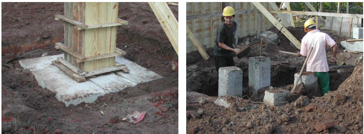
Figura 51 – Pilar sobre bloco de fundação e estacas pré-moldadas de concreto para apoio de bloco.
