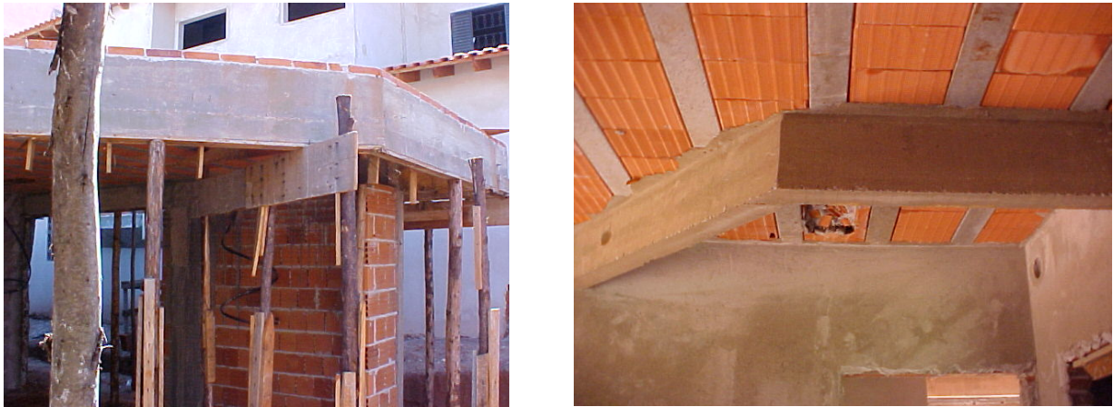
Figura 38 - Vigas com mudança de direção, onde onde os momentos de torção devem ser considerados.
