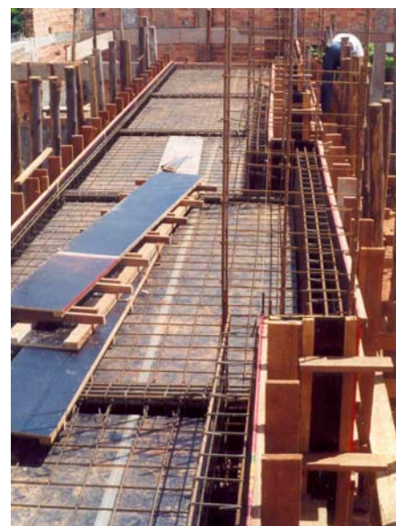
Figura 22 – Lajes maciças sendo concretadas e em construção.
