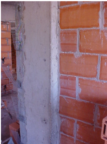
Figura 44 – Detalhes da amarração entre o pilar de edifício e as paredes de vedação.
