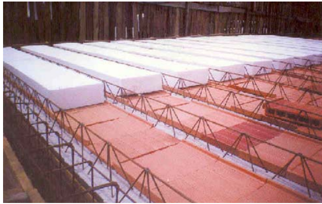
Figura 29 – Laje pré-fabricada do tipo treliçada com enchimento em blocos cerâmicos e de isopor.
