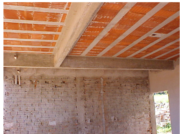
Figura 37 – Exemplos de vigas em sobrado residencial.
