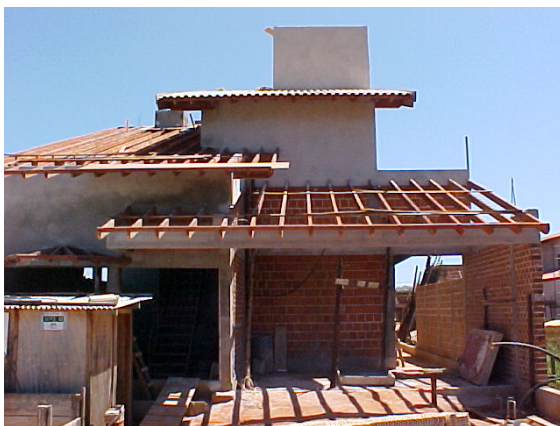
Figura 37 – Exemplos de vigas em sobrado residencial.
