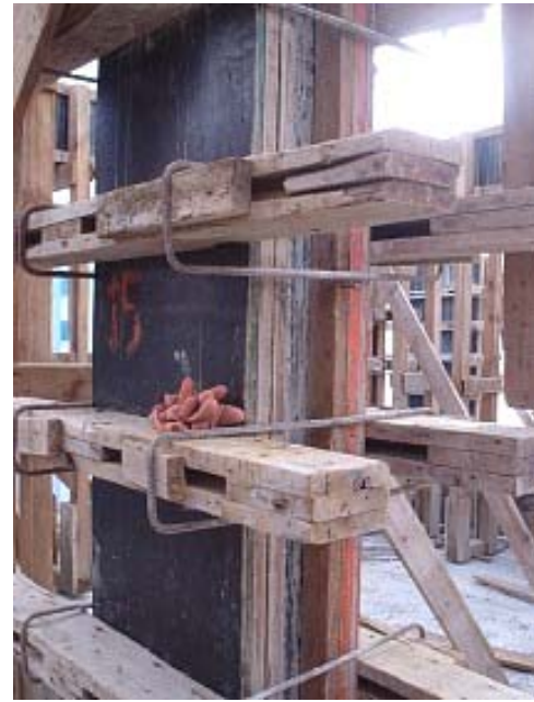
Figura 41 – Montagem de um pilar e detalhe da fôrma.
