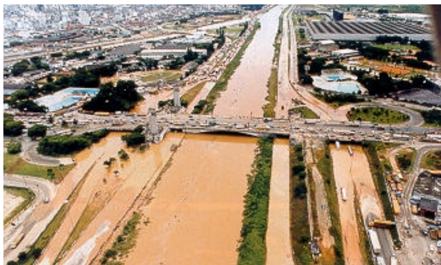
Figura 3.15 Inundação do rio Tietê na ponte das Bandeiras devido a urbanização da cidade de São Paulo.
