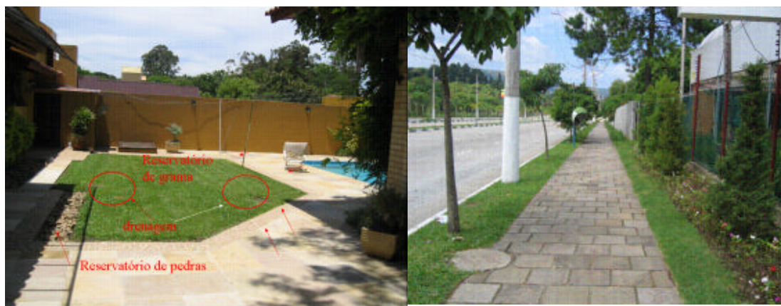
Figura 3.22 Uso de dispositivos para reter a água de áreas impermeáveis (a) foto da esquerda mostra as áreas drenadas de pavimentos para o gramado e dos telhados para reservatórios de pedra: (b) calçadas com gramas laterais para aumentar a infiltração.
