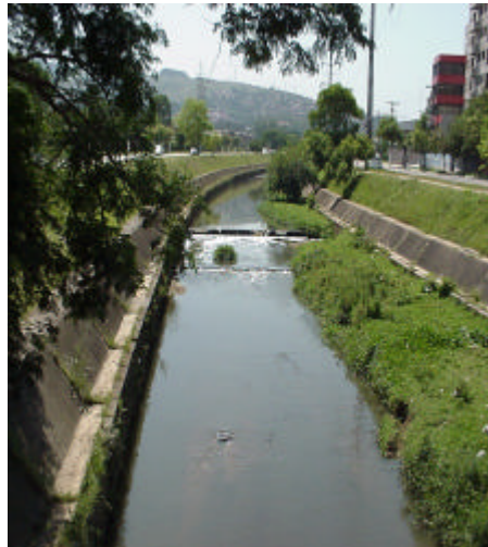
Figura 3.9 Obstruções ao escoamento em canais (Porto Alegre).
