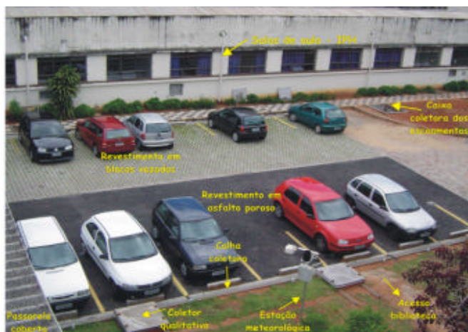
Figura 3.25 Duas áreas experimentais no estacionamento do Instituto de Pesquisas Hidráulicas com bloco vazado e asfalto poroso.
