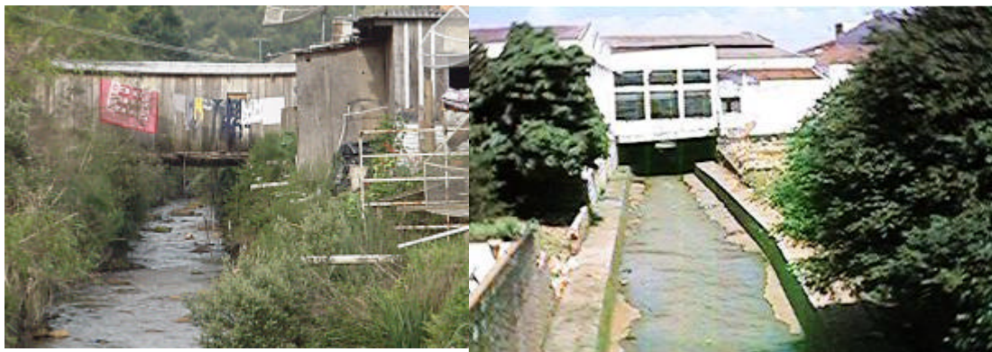
Figura 3.10 Construções na drenagem (Caxias do Sul)
