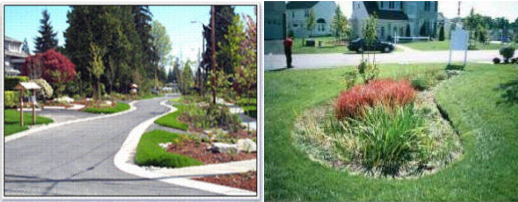
Figura 3.24 Foto da esquerda mostra rua sem meio fio que permitem a infiltração de parte do escoamento nas laterais gramadas. Na foto da direita é apresentada uma área de infiltração num canteiro (incluir fonte).
