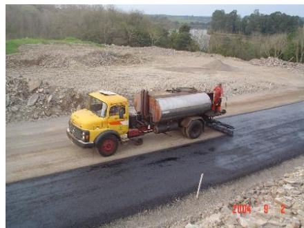
Figura 4: aplicação do asfalto diluído
