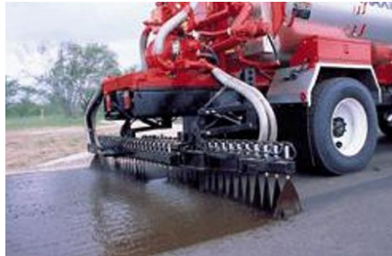
Figura 3: Aplicação da Emulsão Asfáltica
