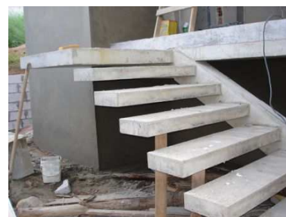
Figura 29 – Degraus engastados de uma escada
