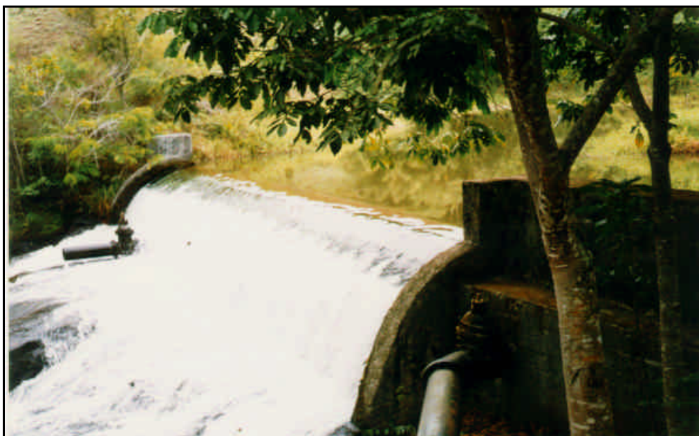
Foto 1 - Tomada Direta com Barragem de Nível
