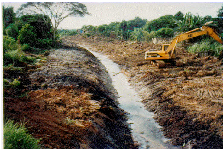
Foto 33 - Retificação de Canal Natural
