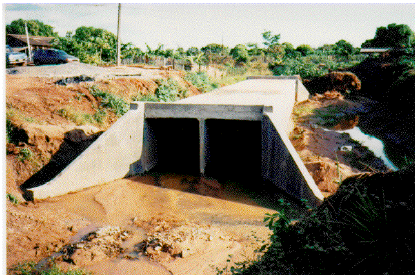
Foto 34 - Galeria de Concreto Armado
