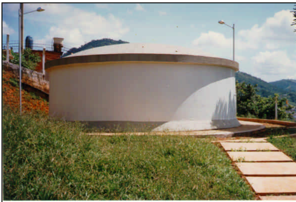
Foto 5 - Reservatório em Concreto Armado Apoiado
