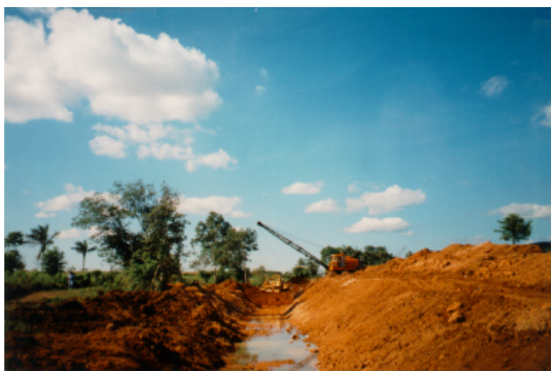
Foto 35 - Dragagem com Drag-line
