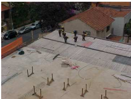
(a) Laje de uma edificação
