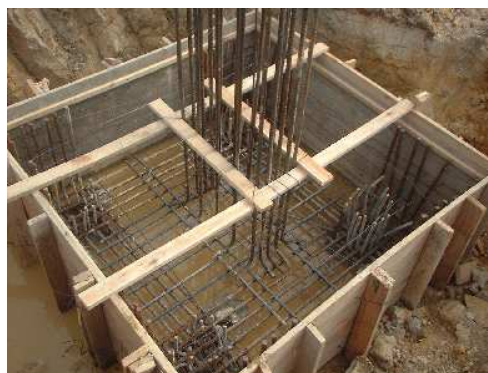
(b) Bloco de coroamento de estaca
