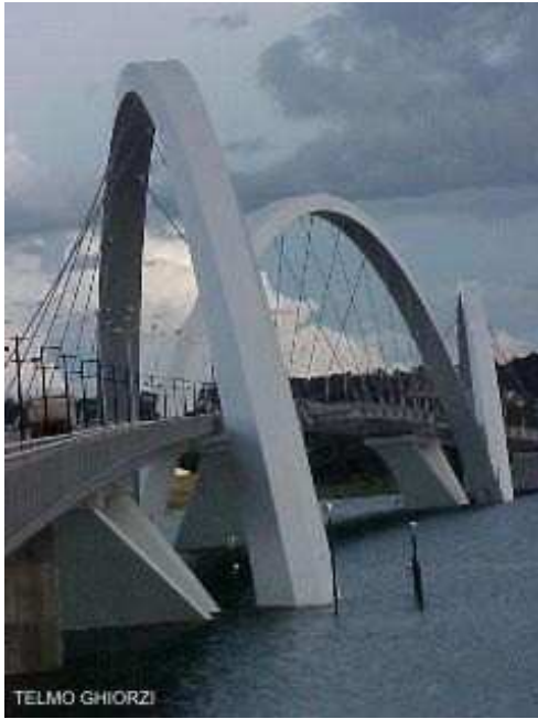
(a) Barras curvas - ponte JK sobre o lago Paranoá - Brasília
