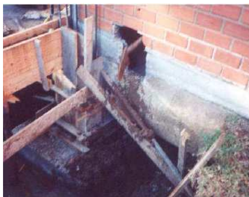
(a) Sapata de fundação
